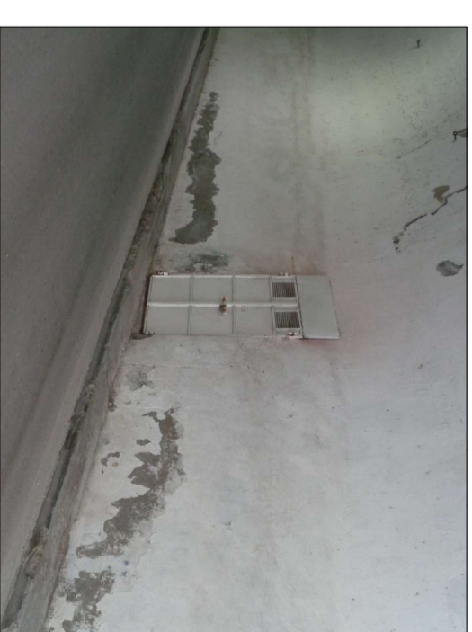
foto 4: veduta dell'ingresso dal tunnel
