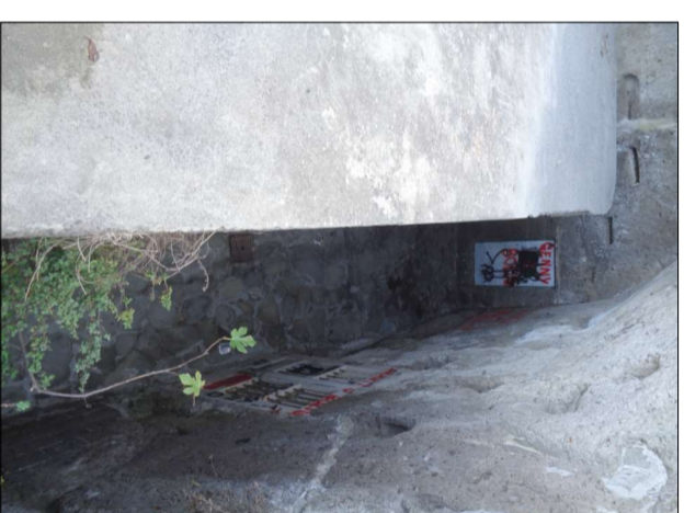
foto 2: veduta dall'alto dell'accesso alla grotta seminterrata
