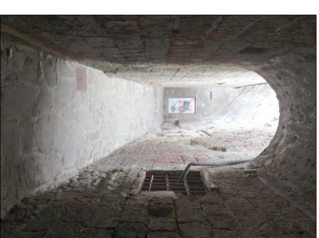
foto 3: veduta dal basso dell'accesso alla grotta seminterrata
