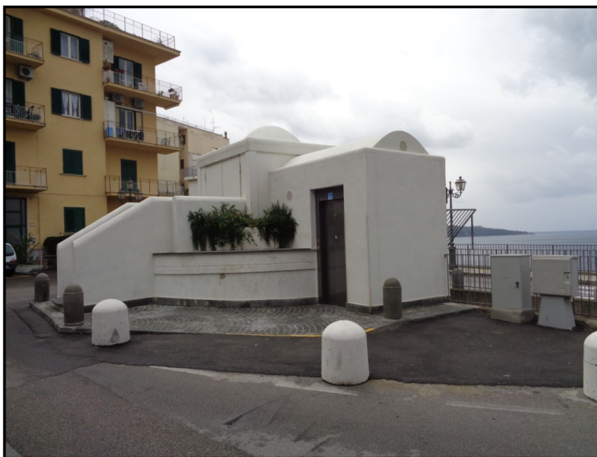
Fig. 4: Piazza dell'Ascensore, edificio d'accesso all'ascensore
