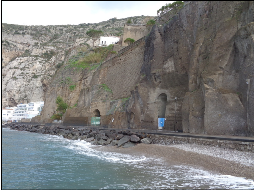
Fig. 11: Veduta della "passeggiata" Via Naviganti Metesi – tratto Alimuri
