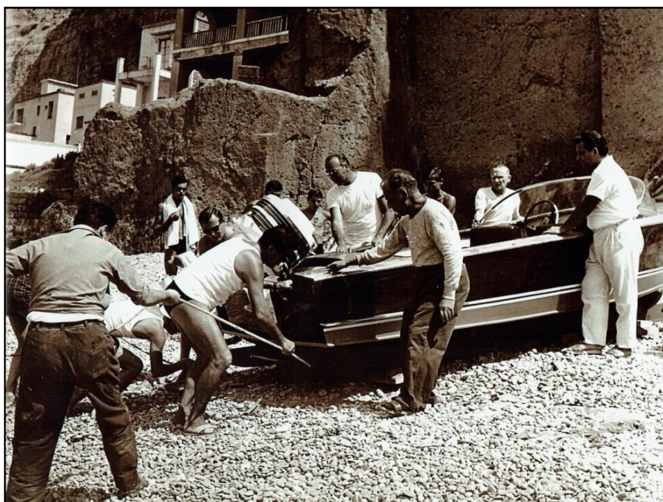
Fig. 27: Marina di Alimuri, Cantiere Cafiero, anni '60
