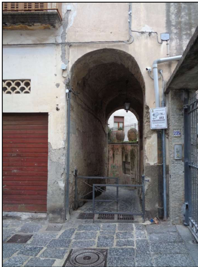
Fig. 19: accesso ai cd. pennini di Alimuri, da via Caracciolo, stato attuale
