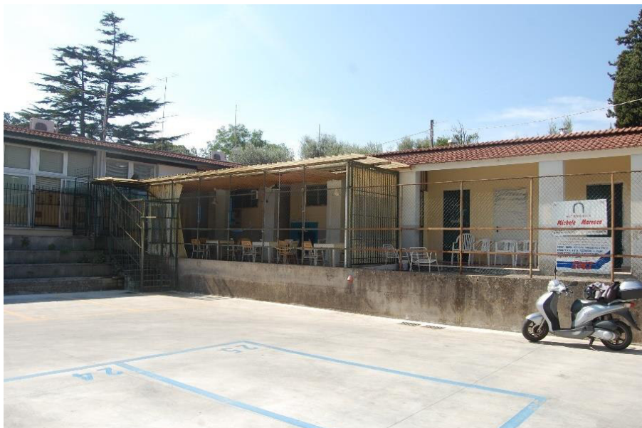
Figura 2 – Struttura esistente, complesso sportivo "Le Querce"
